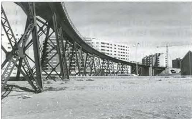
Cargadero de Mineral.
