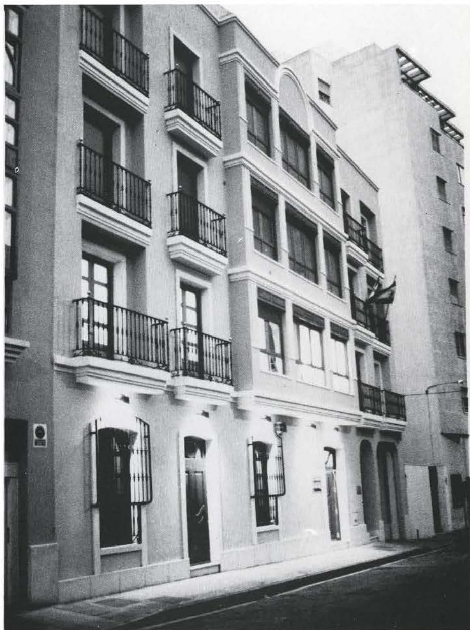
Edificio de la nueva Sede
