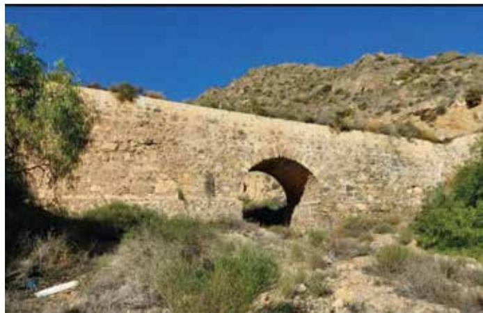
*El Puente de la Garrofa, tipo bóveda de cañón de mampostería, un solo vano, con tímpanos y estribos de mampostería de dolomías; imposta para arranque del arco y largo muro de acceso.*
